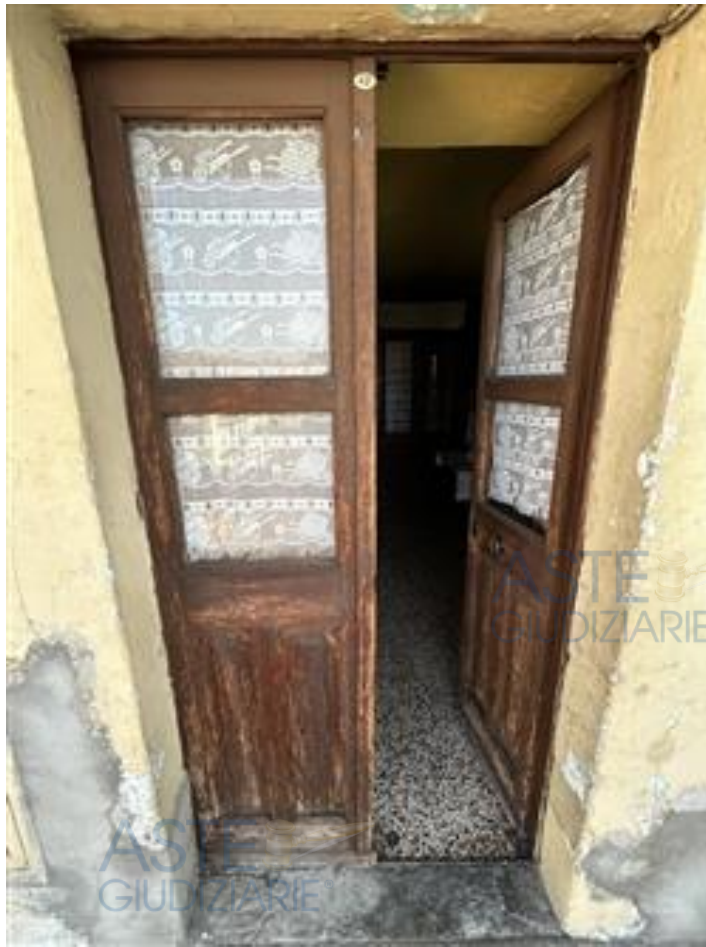
Porta di ingresso all'immobile da ballatoio
