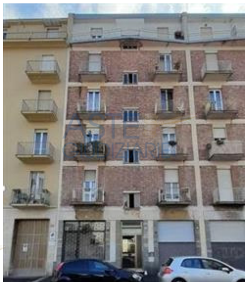
prospetto lato strada
