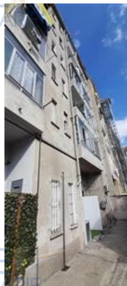
prospetto lato cortile
