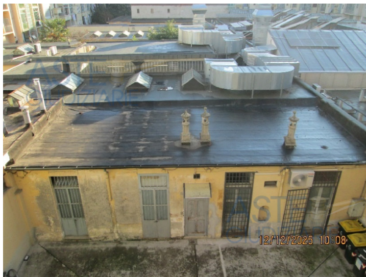
Veduta dall'alto del basso fabbricato
