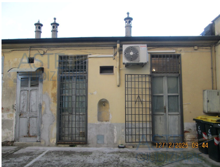
Facciata su cortile del basso fabbricato
