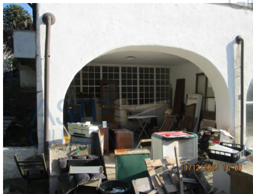
Accesso all'autorimessa dal portico
