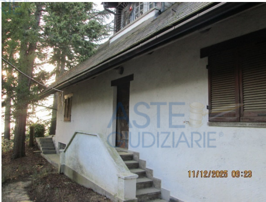
Facciata nord-est, accesso al p. rialzato
