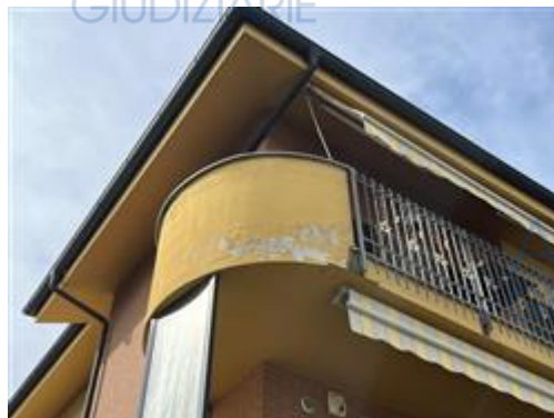
DETTAGLIO BALCONE DELL'U.I. PIGNORATA
