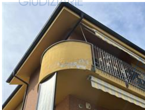
DETTAGLIO BALCONE DELL'U.I. PIGNORATA
