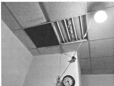
Dettaglio del soffitto ribassato con alcuni quadrotti mancanti
