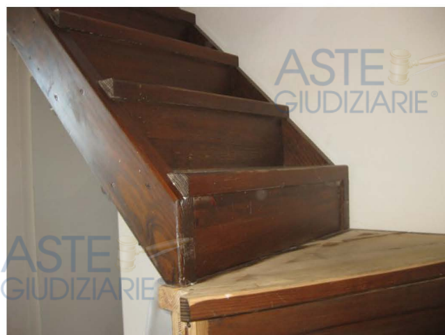
scala di accesso al piano superiore
