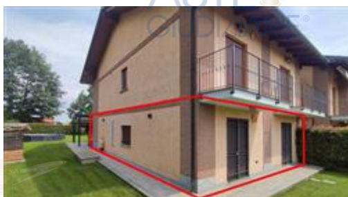
Facciata lato sud ovest
