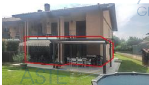
Facciata lato nord
