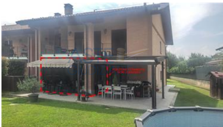
Fotografia con identificazione veranda non licenziata
