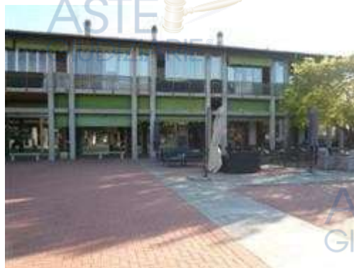
Prospetto sulla piazzetta centrale
