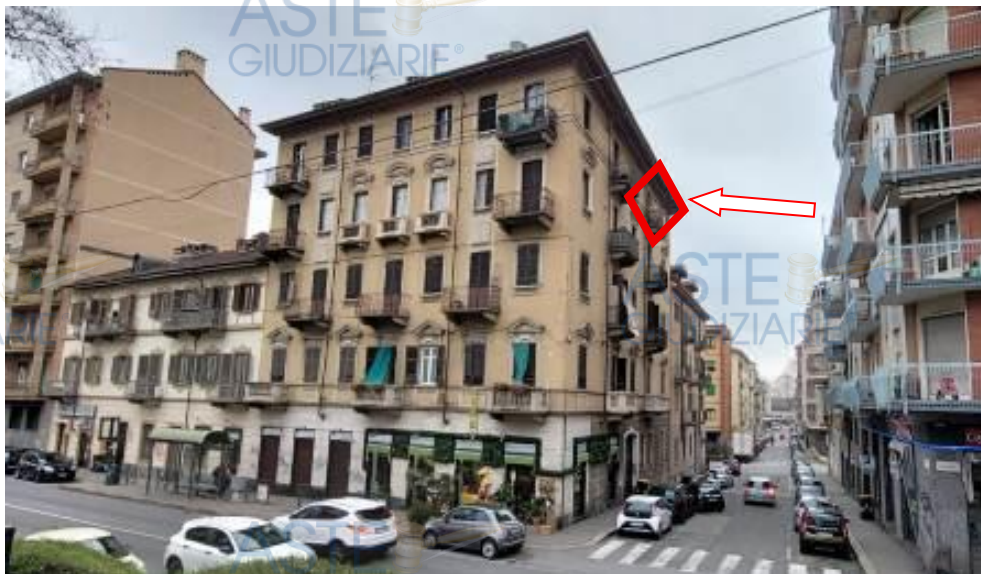
Immobile abitativo in Torino, via Medail n.21 - piano quarto (V FT)
