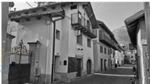
FABBRICATO LATO VIA ROMA
