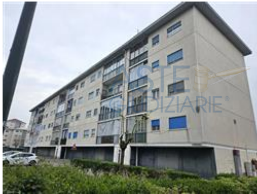
Facciata nord del Condominio
