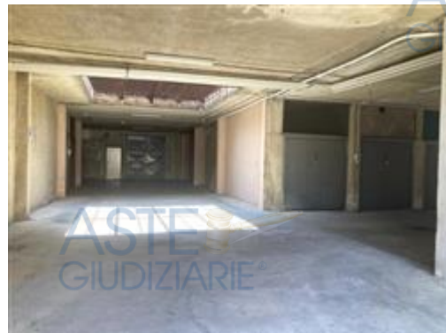
Box in oggetto con basculante aperto
