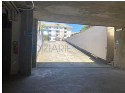
Rampa comune di accesso
