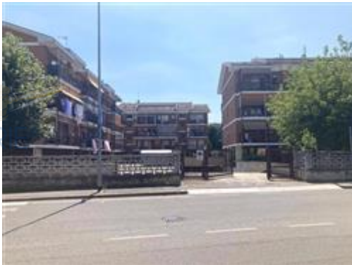
Cancello carraio ingresso
