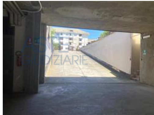
Rampa comune di accesso
