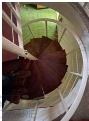
SCALA DI COLLEGAMENTO INTERNA
