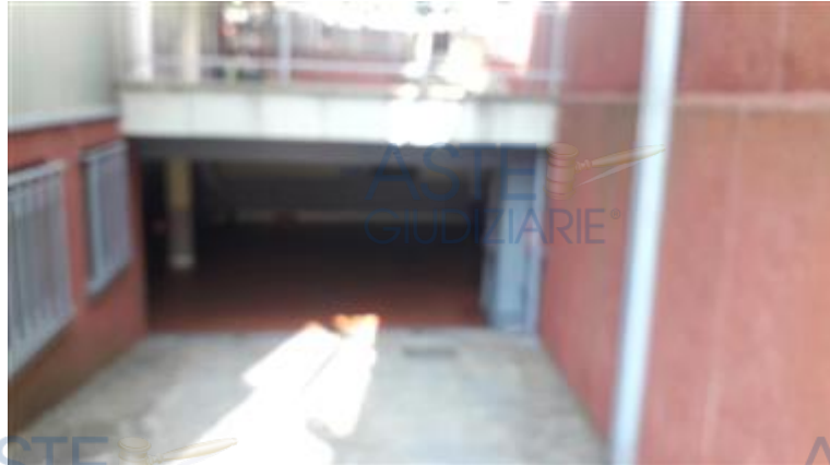
ACCESSO CARRABILE PIANO INTERRATO
