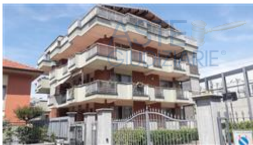
FRONTE SUD EST
