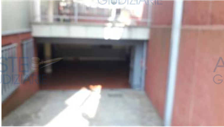
ACCESSO CARRABILE PIANO INTERRATO
