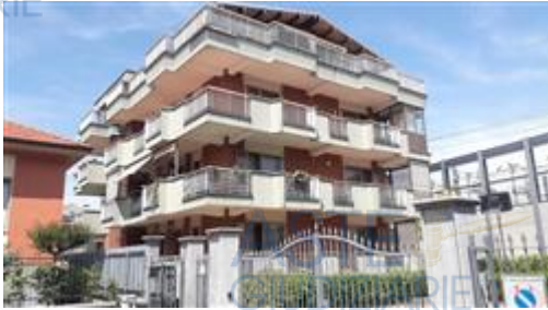
FRONTE SUD EST
