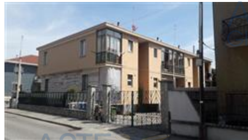
lato sud - ovest - via Rosta
