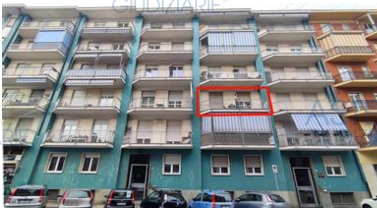
Facciata su via Sestriere con indicazione dell'unità oggetto di perizia
