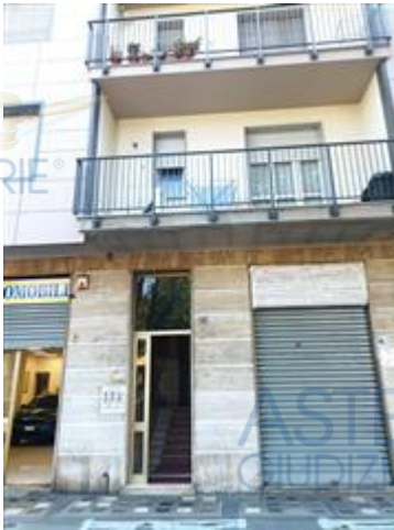
Ingresso pedonale (civico 226)
