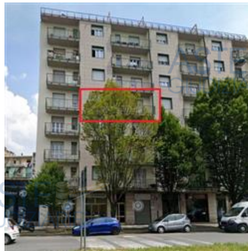
Facciata edificio con identificazione unità immobiliare
