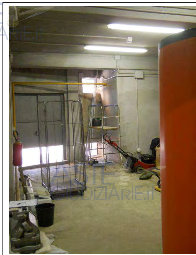
Zona locali tecnici.
