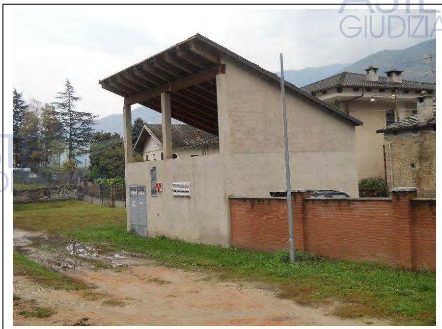
Fabbricato "E" - cabina Enel.
