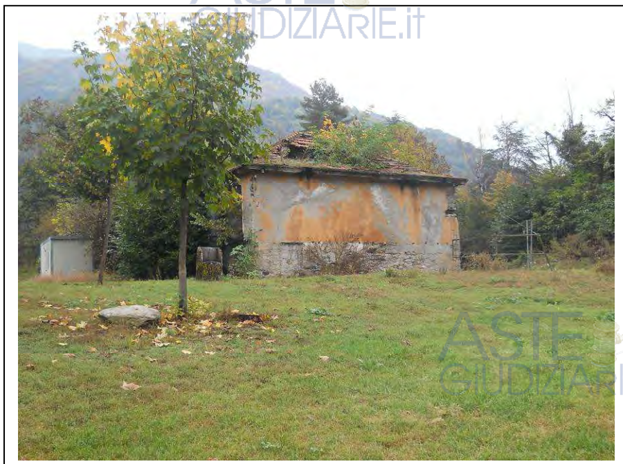
Fabbricato "D" in disuso.
