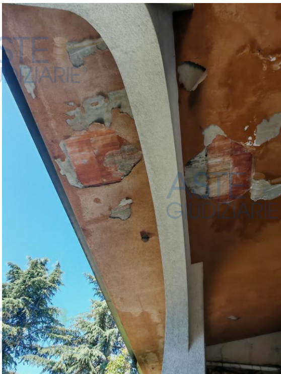
Fotografie scattate in data 28/06/2025 relative ai degradi materici riscontrati all'intradosso del solaio del portico.
