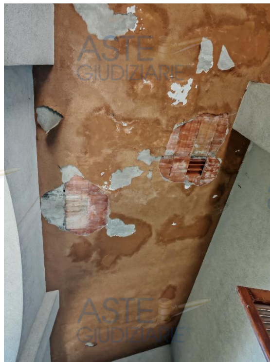
Fotografie scattate in data 28/06/2025 relative ai degradi materici riscontrati all'intradosso del solaio del portico.
