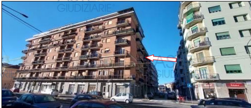
Identificazione del complesso residenziale di strada Lanzo angolo via Caltanissetta
