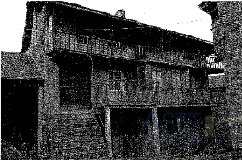
Si tratta di un vecchio immobile a tre piani fuori terra e uno interrato con muratura in pietra, solai in parte a volta in pietra in parte in legno e in parte in cemento armato. La copertura è in lastre di pietra con travi in legno.
