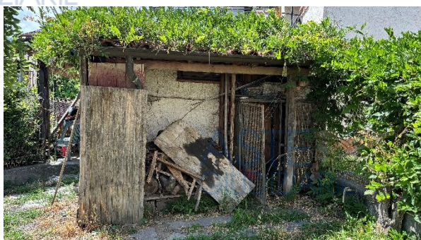
Legnaia posteriore al locale caldaia
