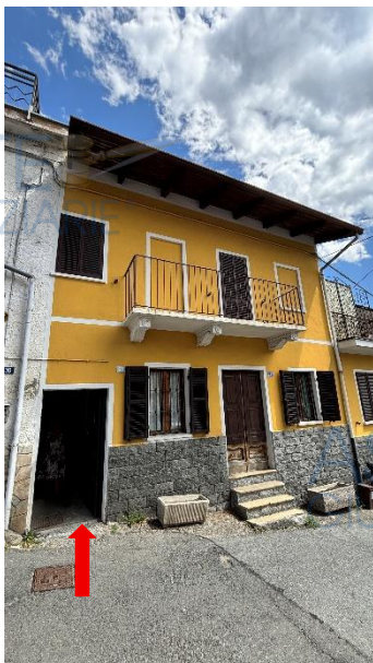
accesso pedonale su via Amprino
