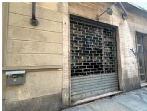
Prospetto via Ormea-vista vetrina negozio
