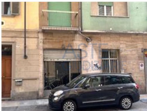
Prospetto via Ormea-vista vetrina negozio
