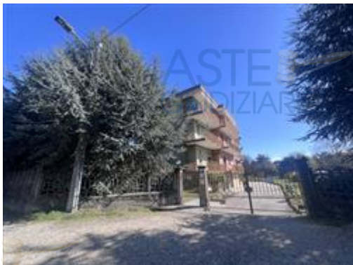
Vista dell'ingresso da strada della Murisa
