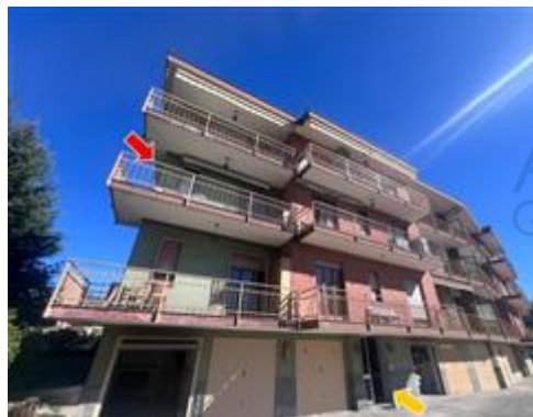
Vista della facciata sud in cui si apprezzano i box auto al piano terra, la freccia arancione indica l'ingresso alla scala di interesse e la freccia rossa individua l'appartamento oggetto di perizia
