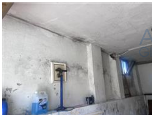
Vista della parete ovest
