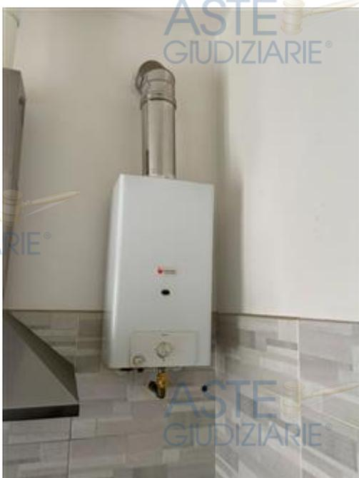
*Boiler a gas di tipo a camera aperta con fiamma pilota.*
