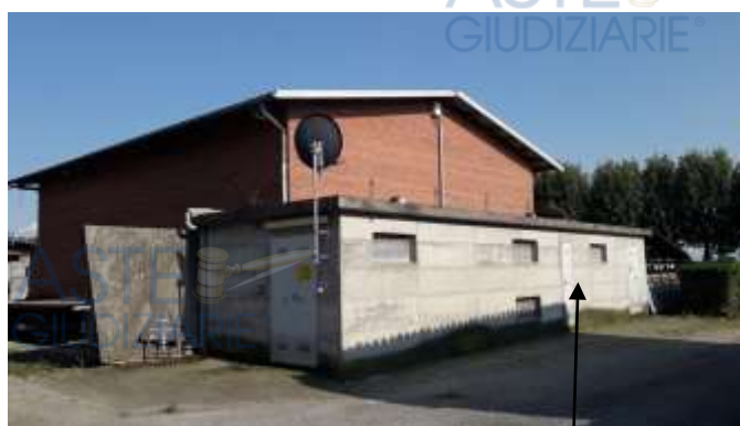
Sub 10- cabina elettrica Enel – porzione a destra
