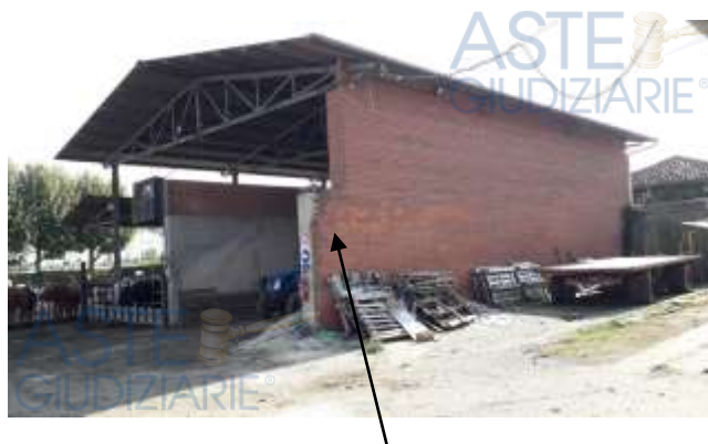
Sub 5 – tettoia aperta
