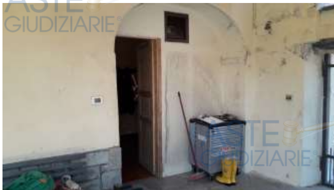
Ingresso sub 5 dal cortile comune
