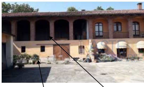
Sub 7 – deposito con soprastante ex fienile
