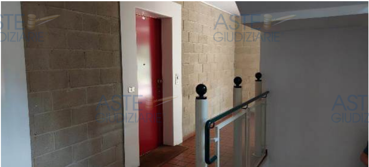
Ingresso dell'appartamento dal vano scale
