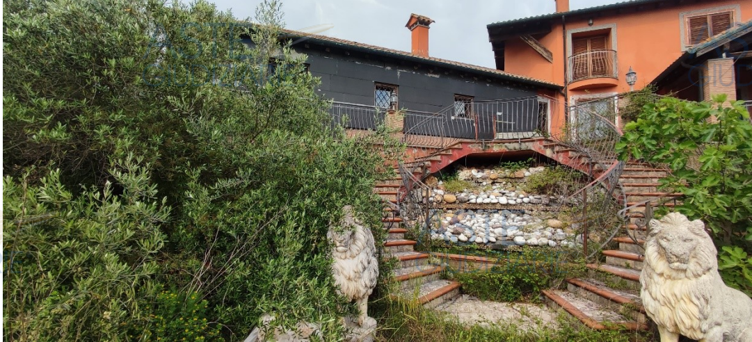
Lavori di isolamento energetico (terminati in data 26/01/2024)
