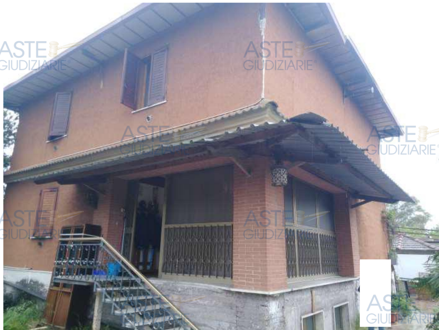
foto del piano terra rialzato
