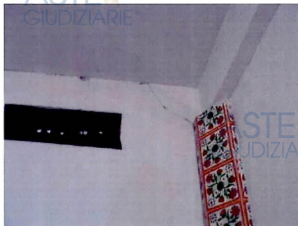
Particolare condizioni pareti
