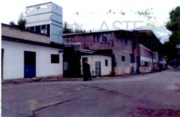
Vista posteriore su locali tecnici
