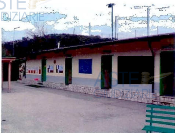
Gli spogliatoi in muratura
