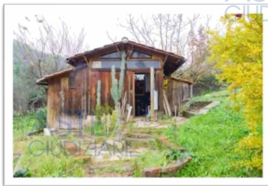
MANUFATTO DA DEMOLIRE
