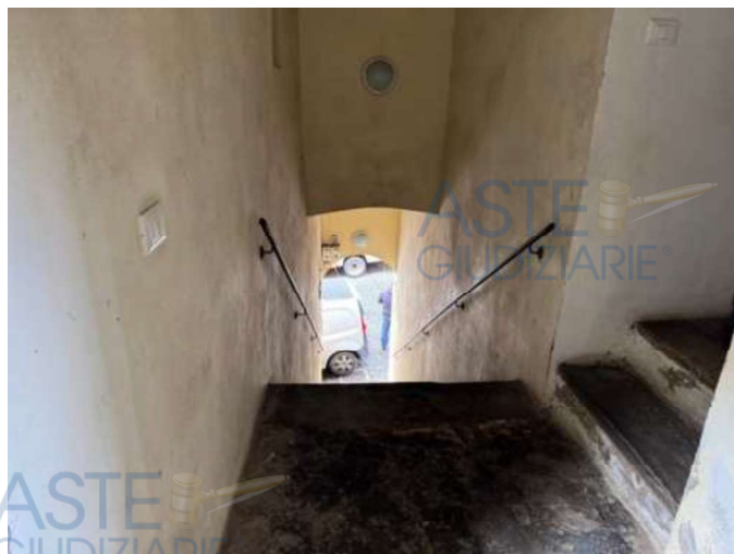
VANO SCALA VERSO VIA ROMA
