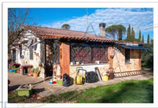
AMPLIAMENTO DA DEMOLIRE
