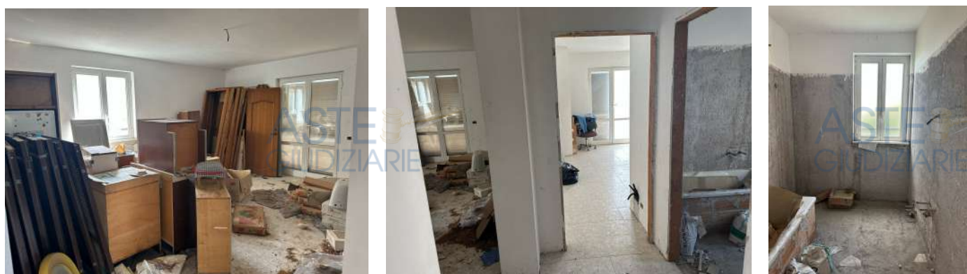
Ambienti posti al Piano Terra – BENE N° 3
