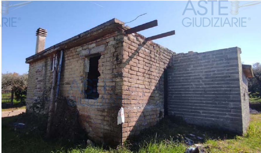
Figura 3.4: Vista di uno dei 3 beni pignorati. P.lla 296
