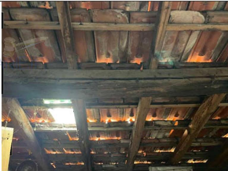
Figura 3– Condizione del tetto di copertura esistente (inflessioni delle travi)
