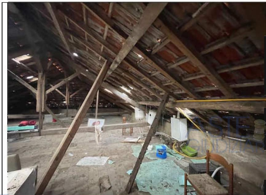
Figura 4– Condizione del tetto di copertura esistente (puntelli)
