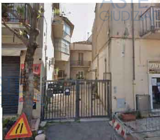
Entrata appartamento e cantina
