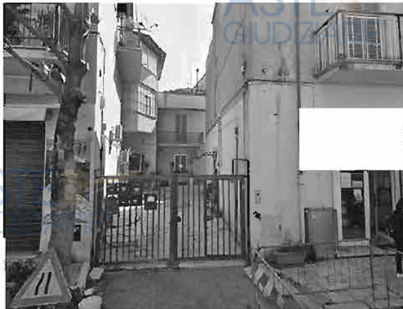
Entrata appartamento e cantina
