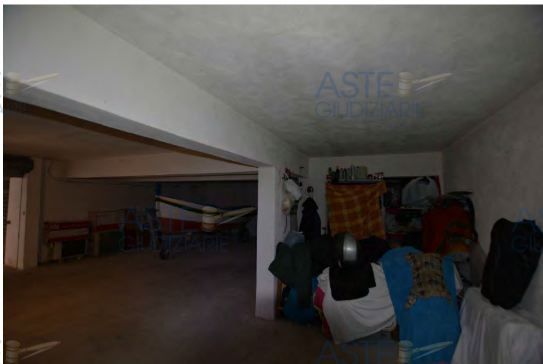
Foto 9 – Magazzino di piano S1
