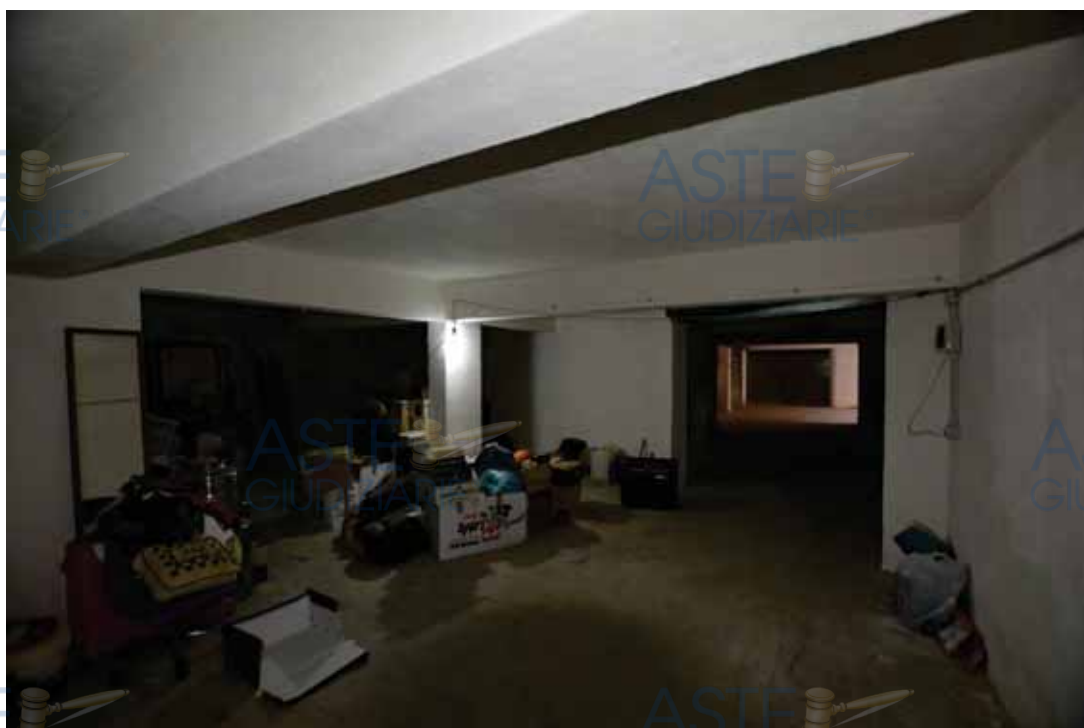
Foto 11 - Magazzino di piano S1
