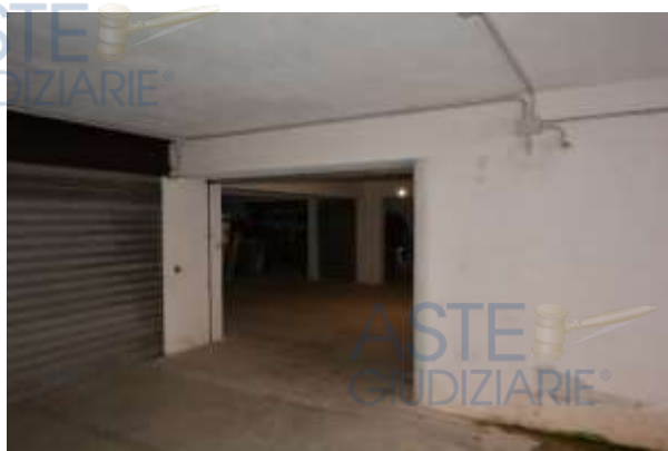
Foto 7 – Ingresso magazzino da corsia di manovra
