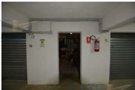
Foto 7 - Ingresso magazzino da corsia di manovra condominiale
