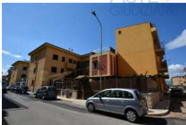
Foto 1 – Palazzina di Via Andrea Doria/Via Bari 18
