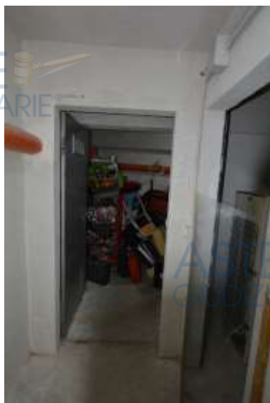
Foto 7 - Ingresso magazzino da corridoio di accesso condominiale
