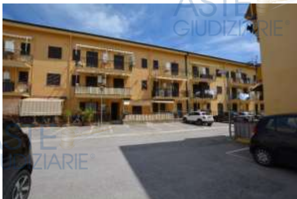
Foto 3 - Edificio di Via Bari n. 18 ad Aspra
