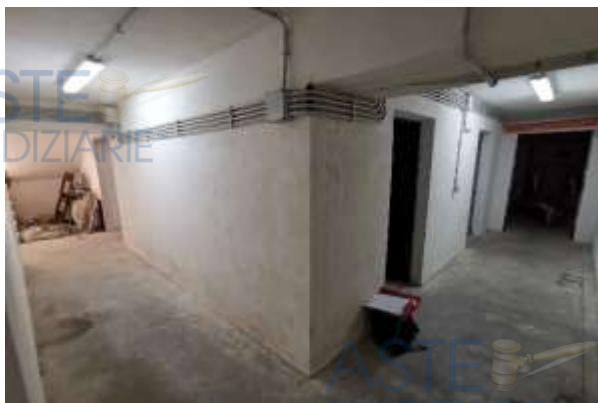
Foto 7 – Ingresso magazzino da corridoio condominiale
