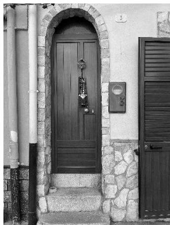
Foto 2-Accesso da largo San Calogero n.3
