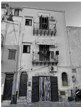
Foto 1-Prospetto su largo San Calogero
