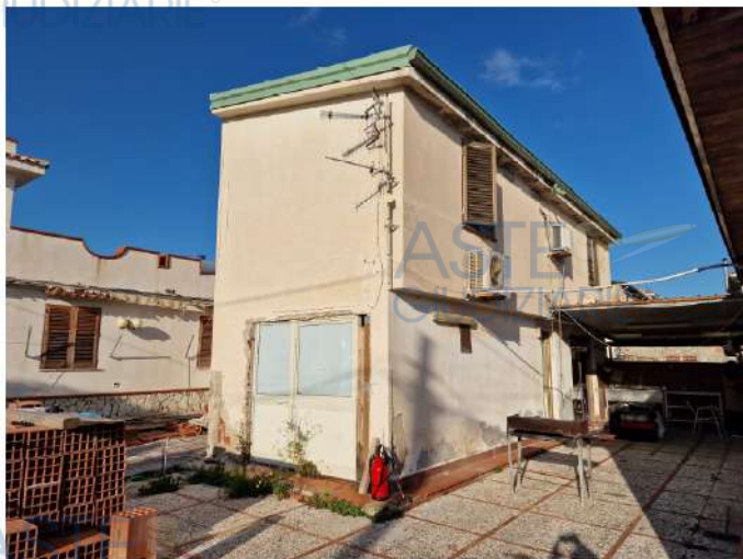
4 | vista del fabbricato 1 da demolire
