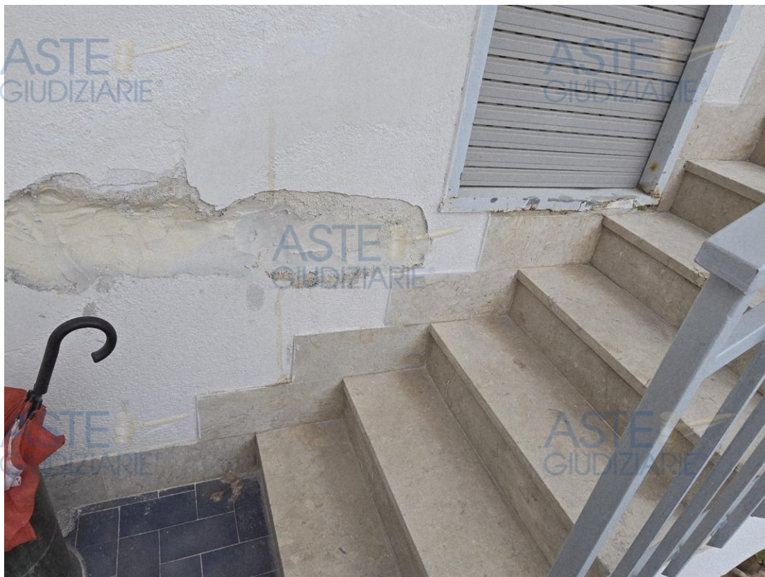
Foto n. 15. Scrostatura di intonaco esterno da umidità in corrispondenza della cucina. La scala di accesso al 1° piano è attaccata al muro esterno che delimita la cucina. L'imbotto della finestra è consunto dalla ruggine.
