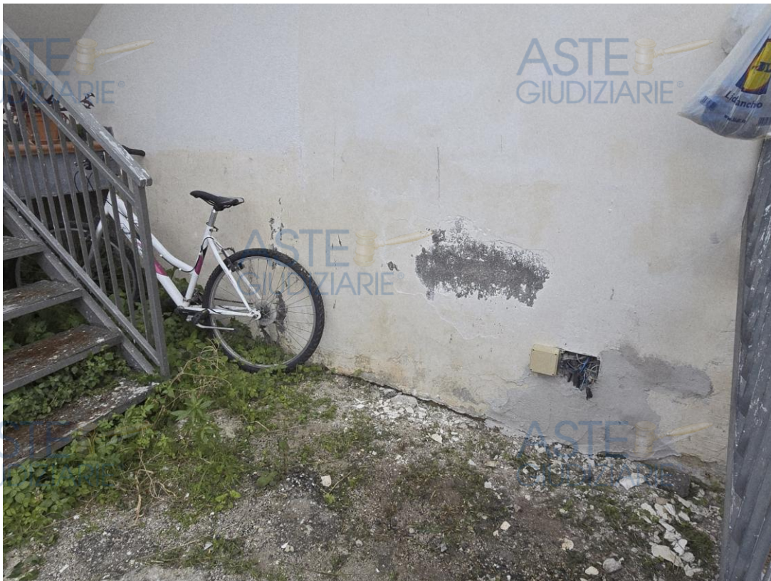
Foto n. 6. Umidità ascendente sulla parete principale del prospetto, in corrispondenza della cucina. Vedi la pianta che segue.
