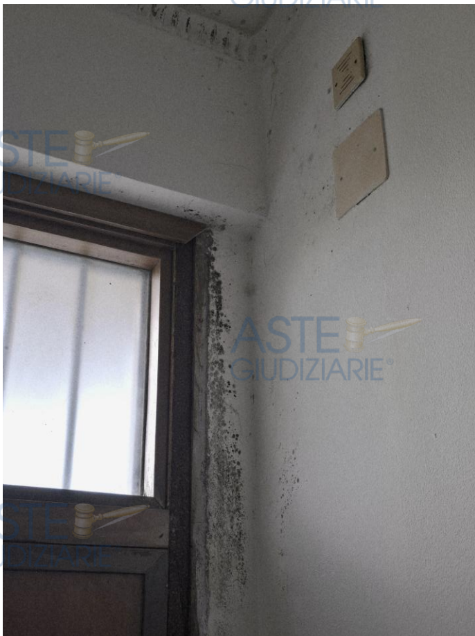
Foto n. 7 e 8. Fenomeni di umidità da condensa ai lati del portone di accesso alla casa.
