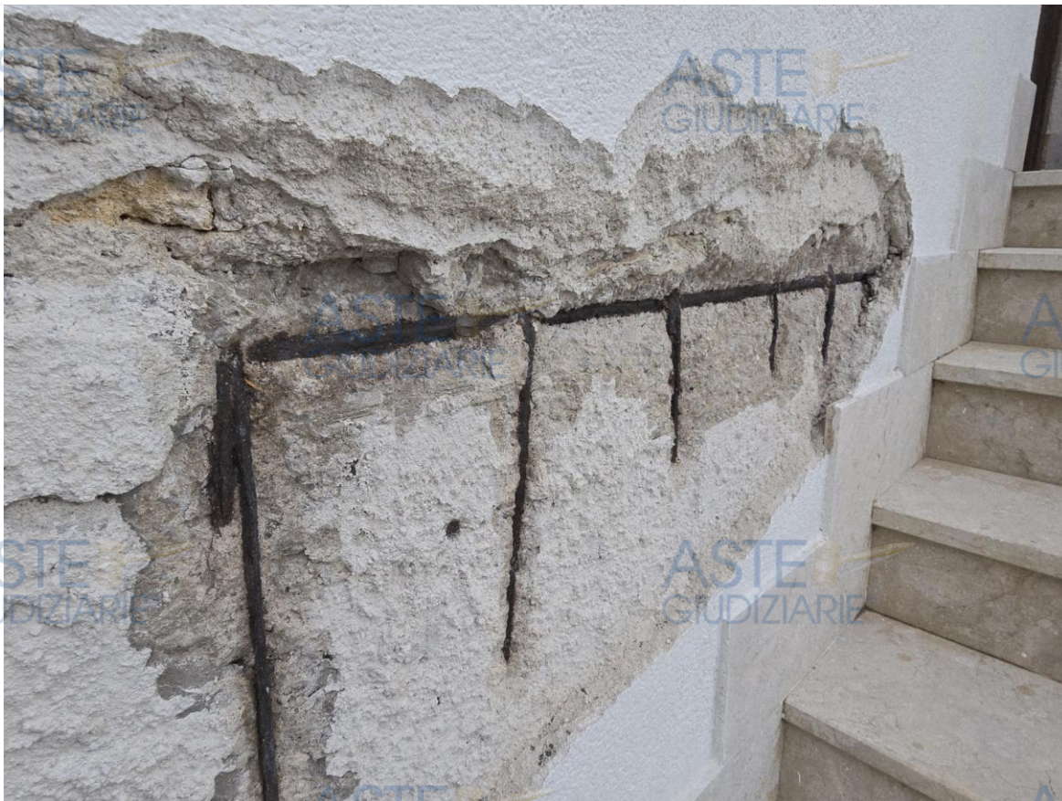
Foto n. 18. Dettaglio della trave con i ferri ormai diminuiti di sezione e fortemente ossidati.
