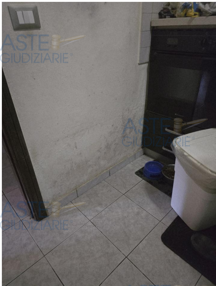
Foto n. 11-12. Umidità ascendente nell'altra parete della cucina. Vedi la pianta che segue.
