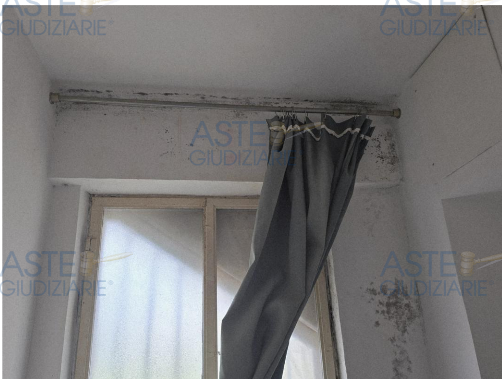
Foto n. 13 e 14. Il bagno con umidità da condensa e
