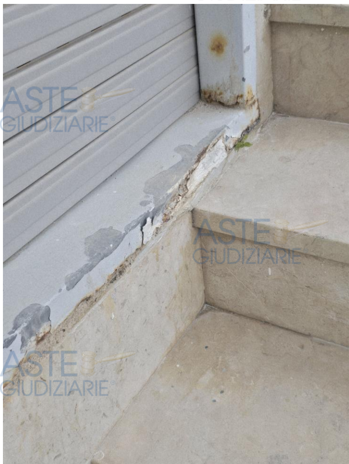
Foto n. 16. Dettaglio dell'imbotto della cucina ormai fradicio. Foto n. 17. La trave in c.a.a vista corrisponde a quella del bagno, foto n. 14.
