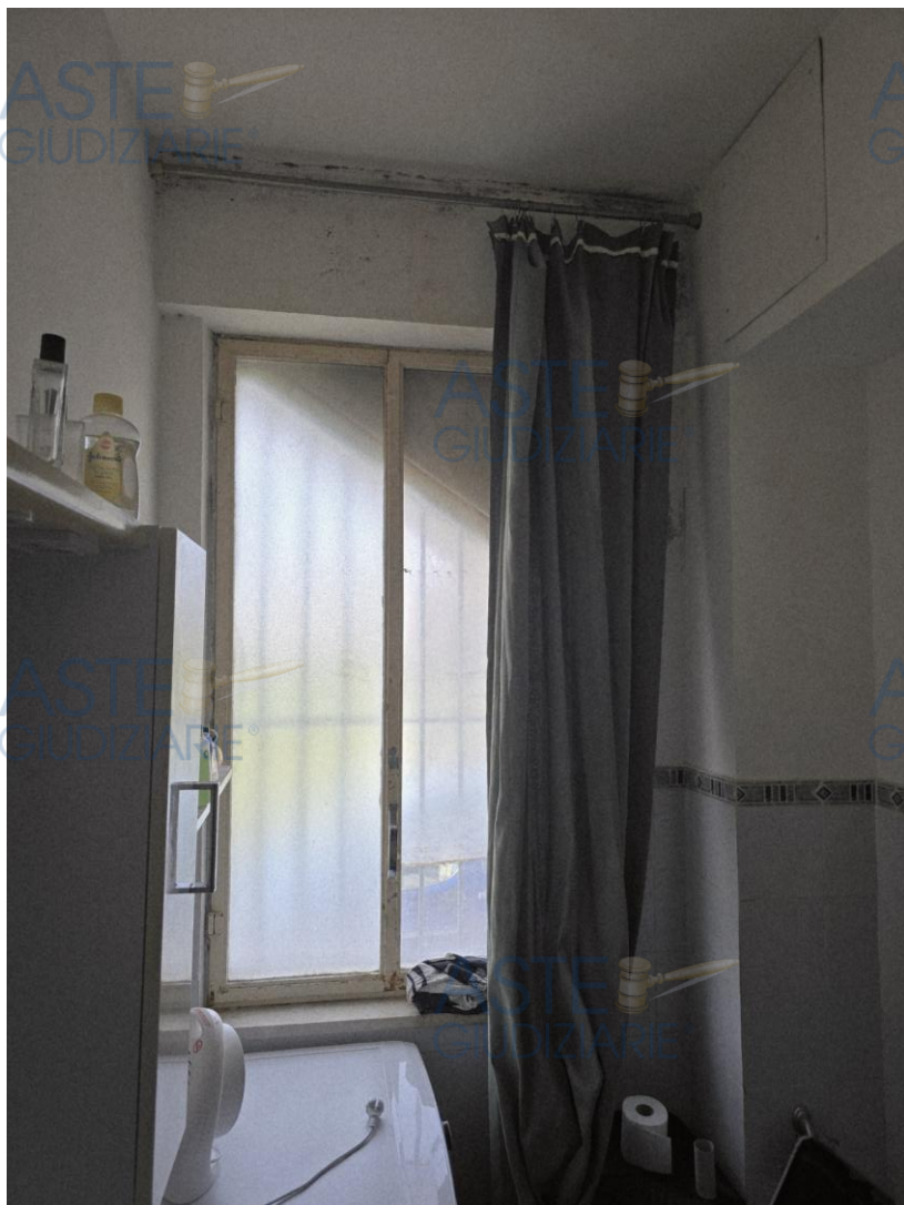
Foto n. 13 e 14. Il bagno con umidità da condensa e
