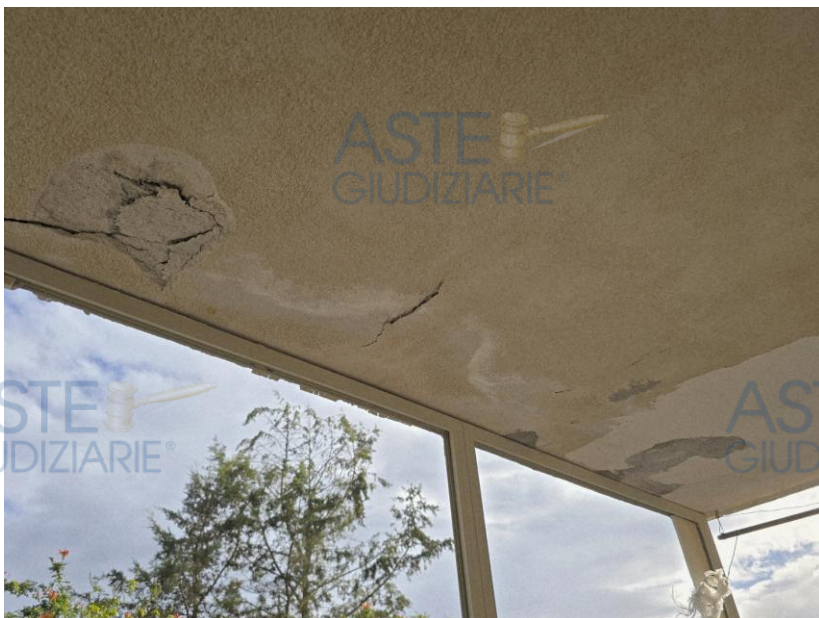
Foto n. 1. Calcinacci in terra sul terrazzino. Foto n. 2. Il sotto balcone del primo piano copre il detto terrazzino.
