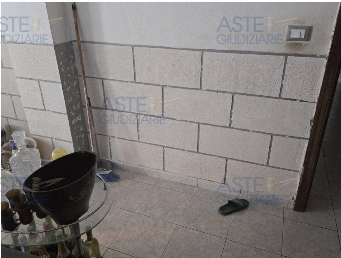
Foto n. 22. Sempre il salotto con il lambries realizzato dall'esecutato così da eliminare l'umidità.
