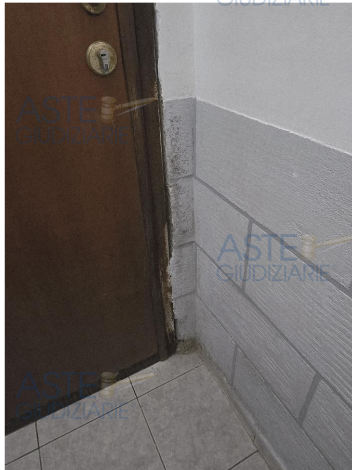
Foto n. 7 e 8. Fenomeni di umidità da condensa ai lati del portone di accesso alla casa.
