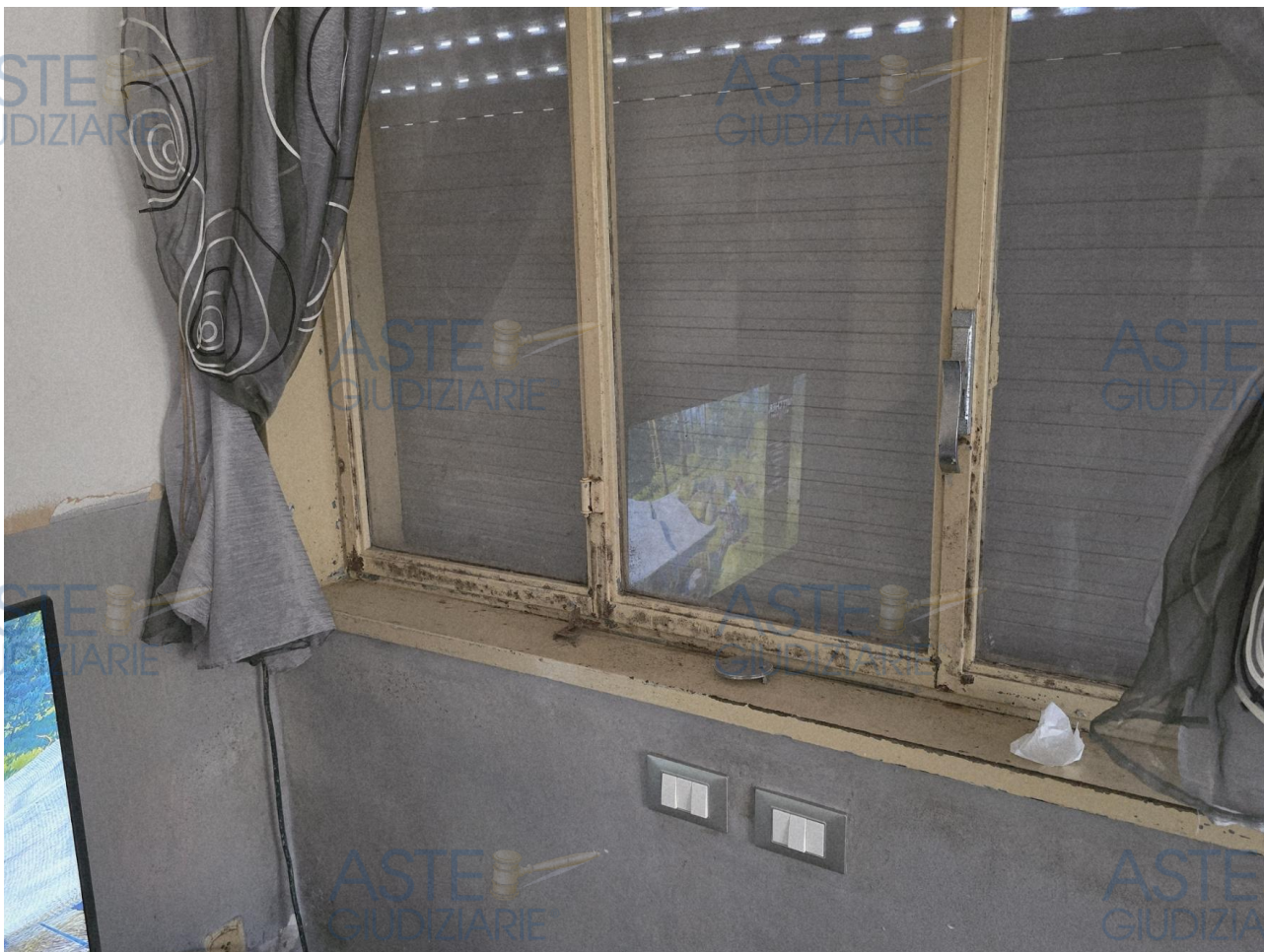
Foto n. 25. Dettaglio dell'infisso del salotto in pessime condizioni.
