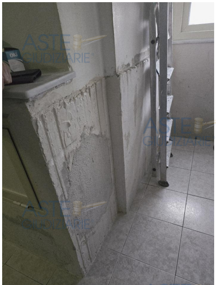
Foto n. 11-12. Umidità ascendente nell'altra parete della cucina. Vedi la pianta che segue.
