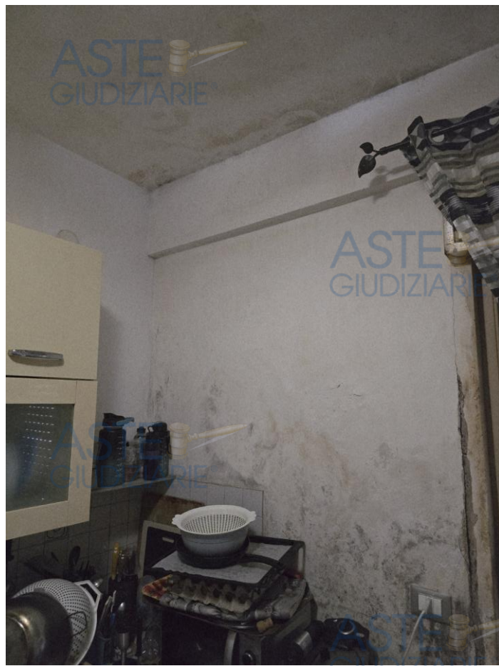
Foto n. 9-10. Forte umidità nella parete della cucina che confina con la scala. Vedi la pianta che segue.
