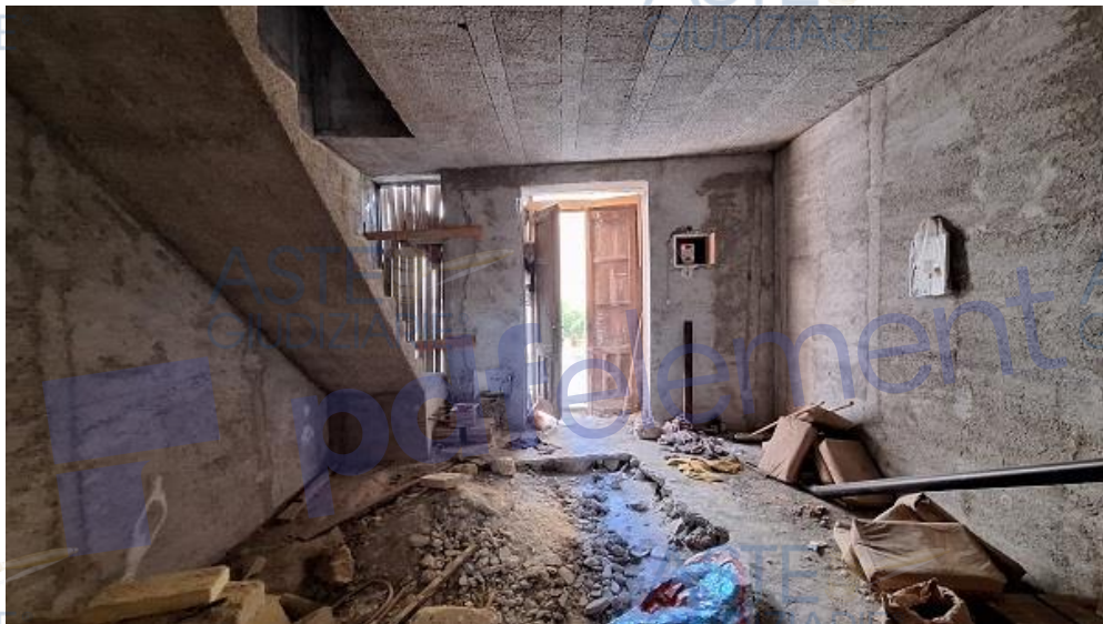
Vista verso l'ingresso - P. T.
