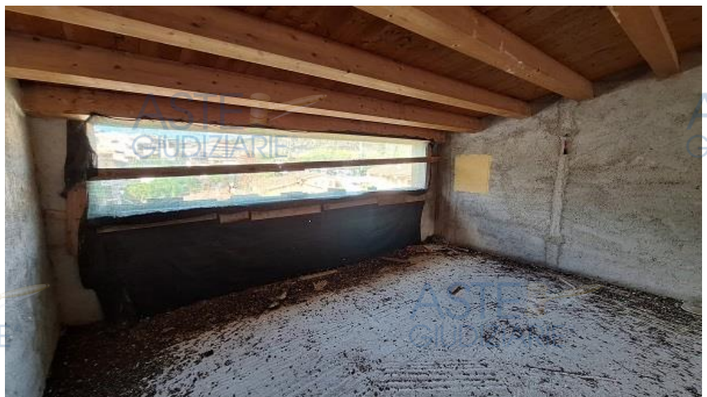
Vano sottotetto - P. 3
