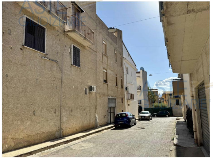
2 - foto del fabbricato da via Cap. Magg. Bondi
