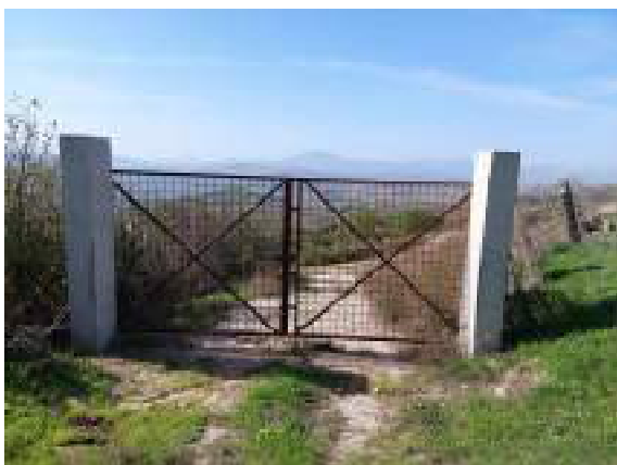
Foto 3 – Accesso al corpo "B"
